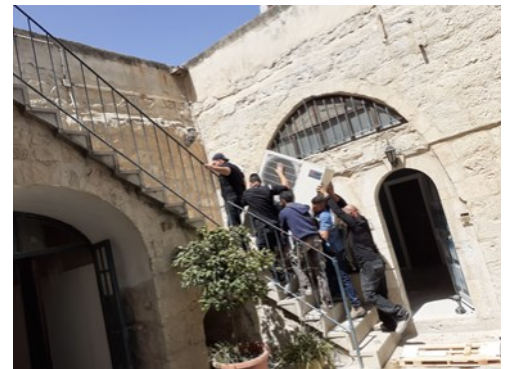
Transport Klimaanlage auf das Dach
